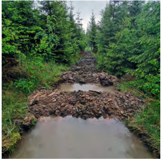
Obrázok 36a, b Revitalizácia vrstevnicovej technologickej linky alebo linky s malým sklonom. Infiltračné opatrenie typu Jama-Hrázda-Jama, s dôrazom na podporu biodiverzity (fotografia: © Miroslav Kubín)
