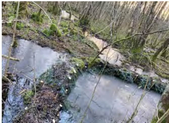
Obrázok 30d Príklad hrádzky postavenej na blokovanie dvoch odvodňovacích kanálov s použitím konárov invázných drevín ako štruktúry a miestnej vlhkej rašeliny ako výplne (fotografia: Endre Grüner Ofstad)
