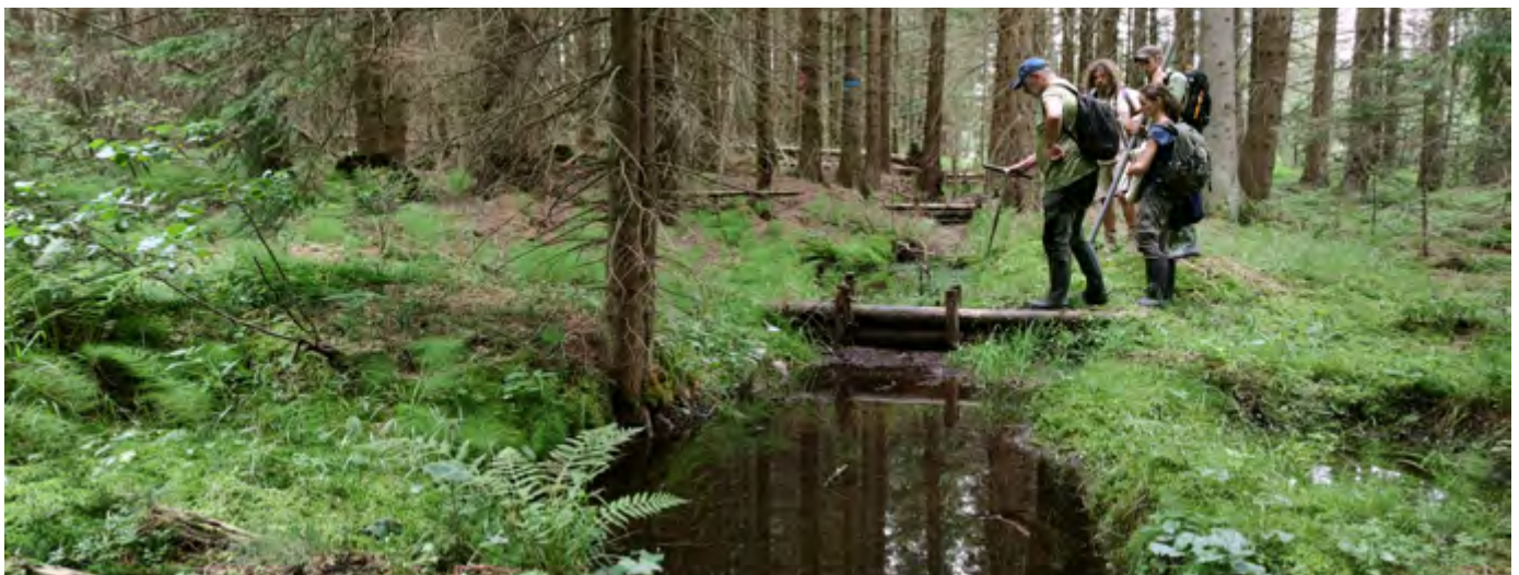
Obrázok 9 Hrádzky zlepšujú vodný režim lokality Tisovnica, ktorá bola v minulosti odvodnená umelými vodnými kanálmi (pozri aj obrázok 22, fotografia: © Pavol Polák)
