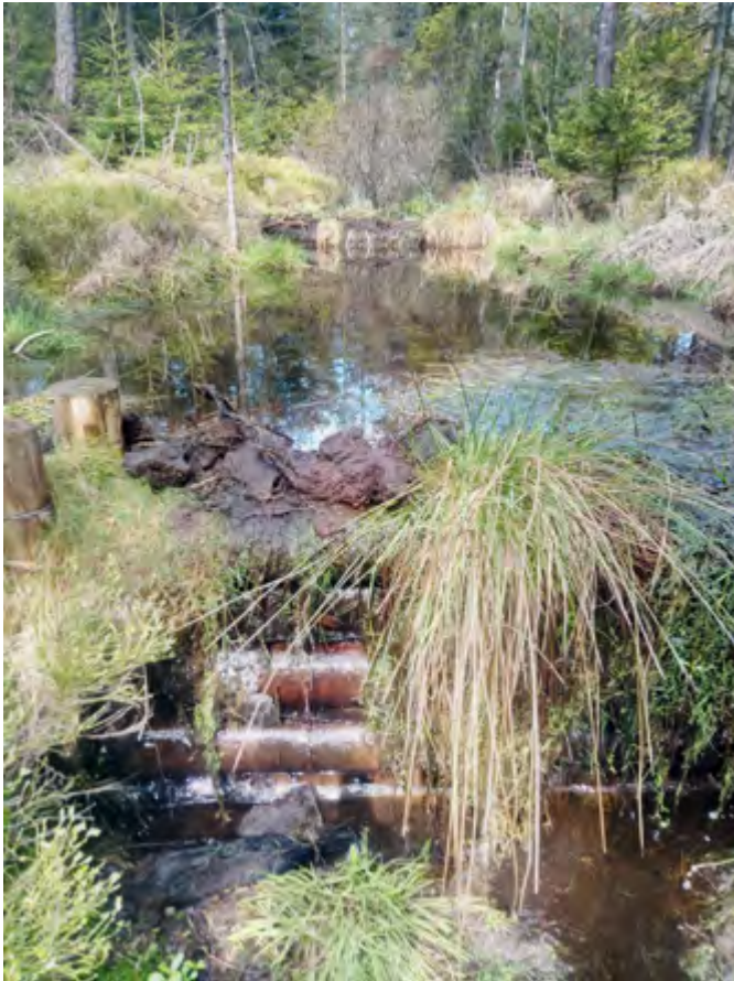
Obrázok 22 Zrubové hrádze vyplnené vlhkou rašelinou na odvodňovacom kanáli v Tisovnici na Slovensku. Miesto bolo predtým mokradovým lesom s borovicou Čelakovského, odvodnené a vysadené na lesnícke účely v 70. rokoch 20. storočia. Priehrady boli postavené v roku 2011, opravené v roku 2019 (fotografia 2022) a sú súčasťou obnovy, ktorej cieľom je obnoviť otvorenejšie biotopy mokradových lesov v lokalite. Nedávnu mokrú rašelinu na vrchu priehrady pridal bobor vodný, ktorý sa v lokalite dočasne zdržiava. Pozri tiež príklady návrhov priehrad účinných na menších kanáloch na obrázkoch 11c a 11d nižšie (fotografia: Duncan Halley)
