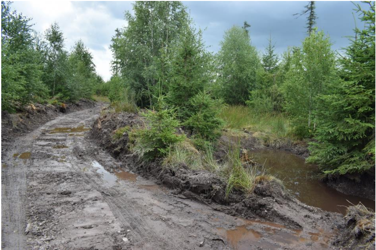
Fotodokumentácia - Obrázok 7: Úprava využívanej odvoznej cesty s vytvorením retenčného jazierka s litorálom na okraji cesty.
