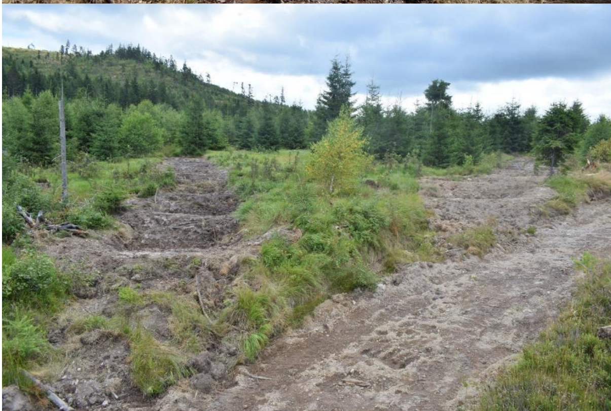
Fotodokumentácia - Obrázok 2: Revitalizácia nepotrebných liniek metódou Jama-Hrádza-Jama, stav pred a po realizácii
