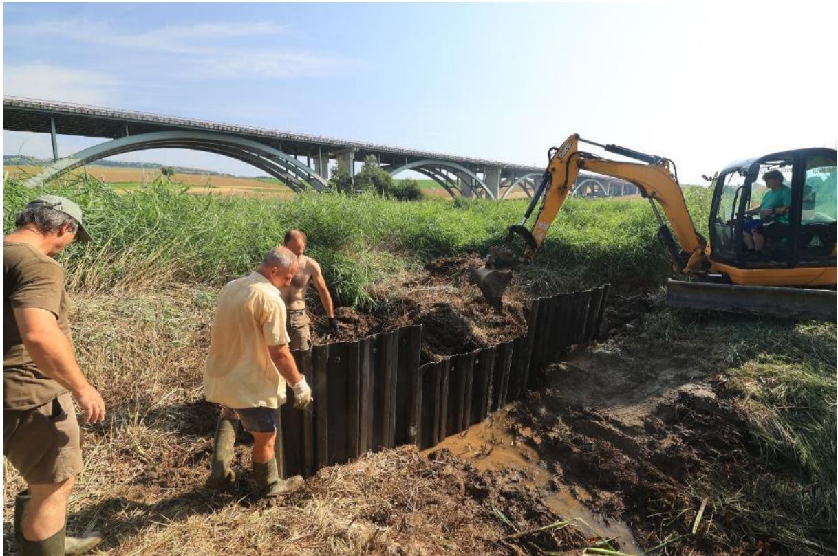
Obr. 1. Budovanie larsenovej steny
