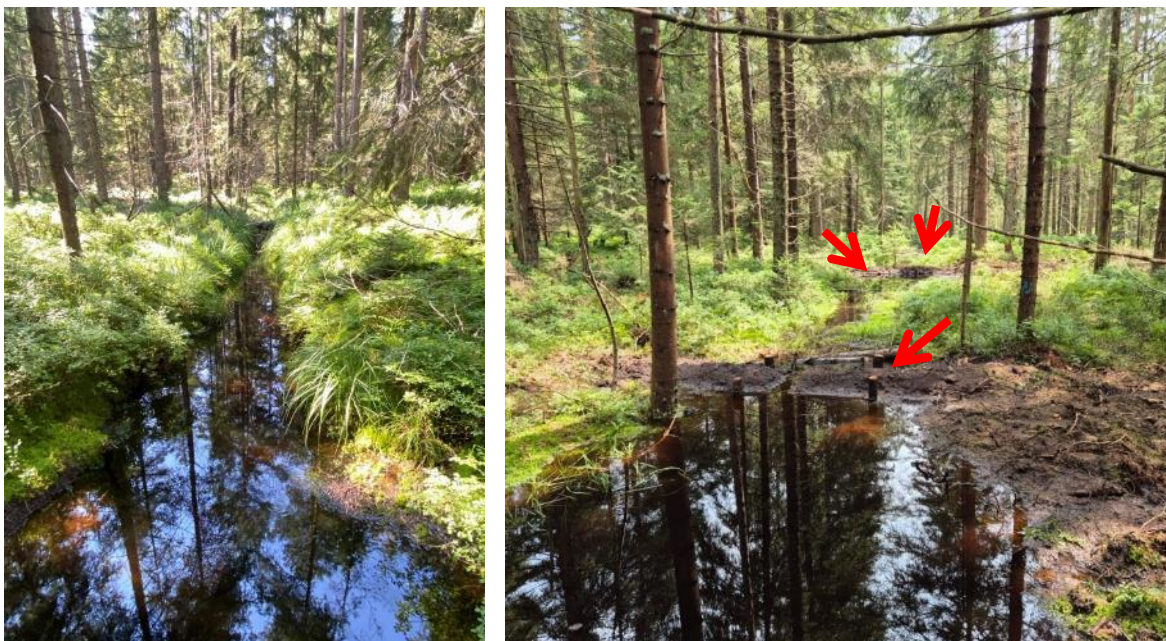
Foto 6 – nové prehrádzky na kanáli 2, záber pred a po vykonaných opatreniach, šípky ukazujú jednotlivé prehrádzky
