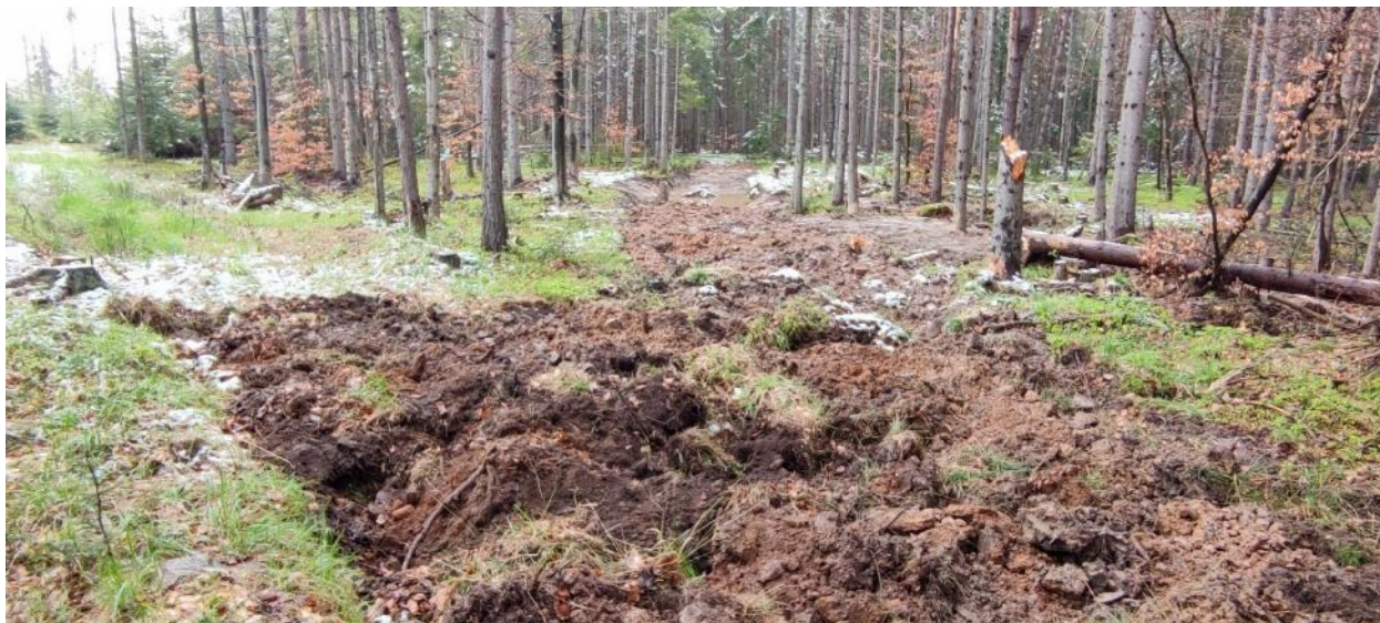
Obrázok 11 Odstránenie nepoužívanej lesnej cesty formou prekopenia vrchnej vrstvy počas prác.
