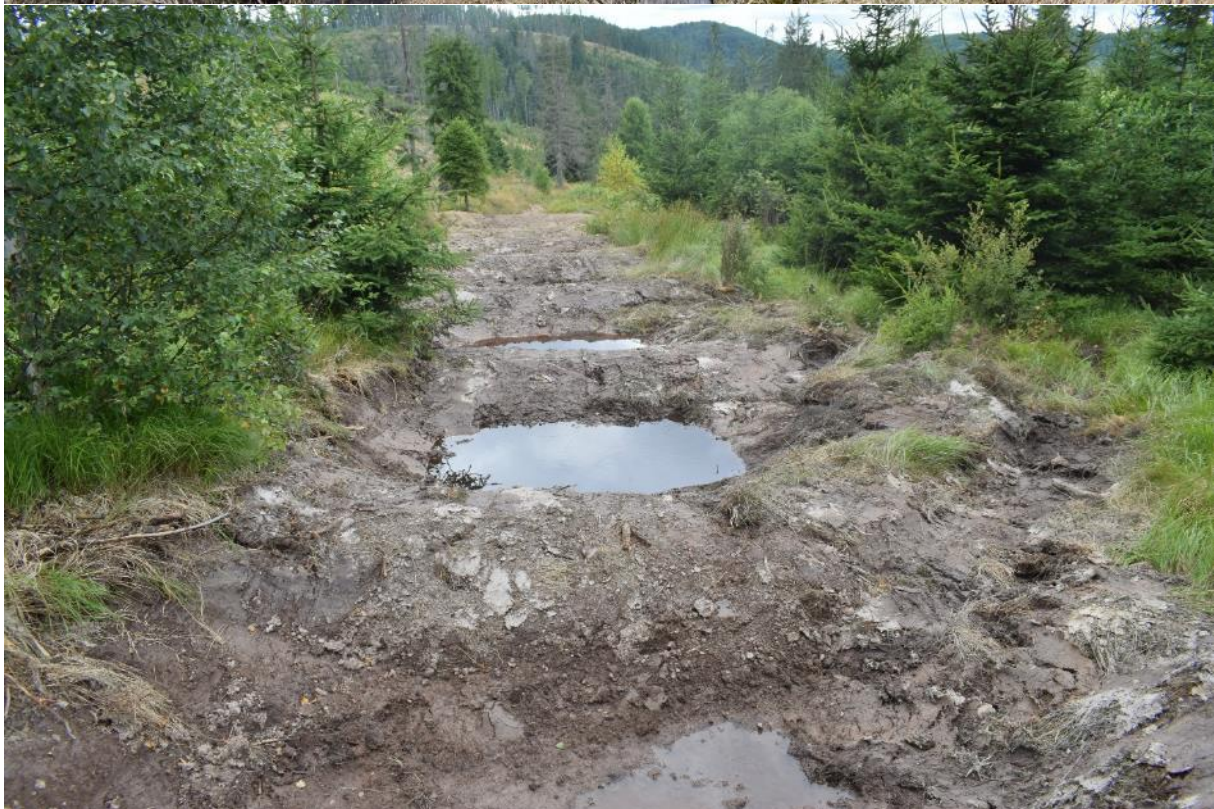
Fotodokumentácia - Obrázok 1: Revitalizácia nepotrebných liniek metódou Jama-Hrádza-Jama, stav pred a po realizácii
