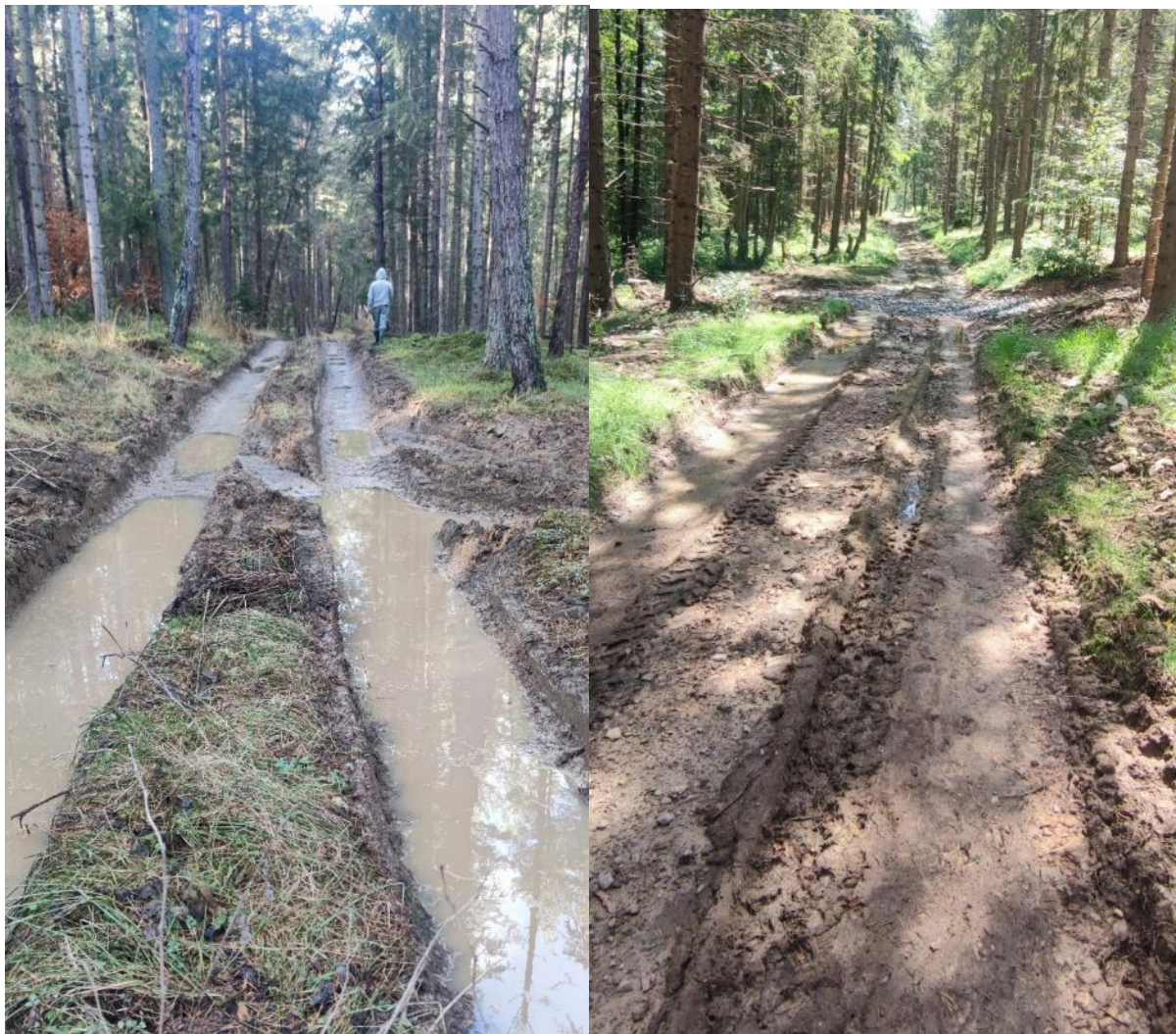
Obrázok č.4 : Revitalizácia lesnej cesty formou prekopania utlačených vrstiev cesty, s infiltračnými a vsakovacími prvkami po okrajoch, stav pred a po realizácii
