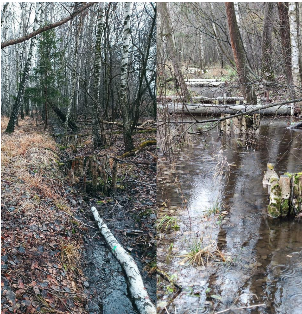
Obrázok 3: Rozlievanie vody z kanála pri slatine po zasypaní vybraných úsekov.
