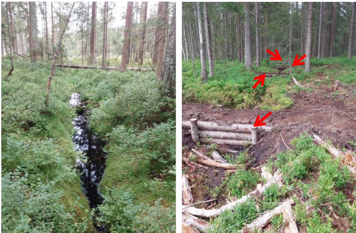
Foto 4 – nové prehrádzky na kanáli 1, záber pred a po vykonaných opatreniach, šípky ukazujú jednotlivé prehrádzky
