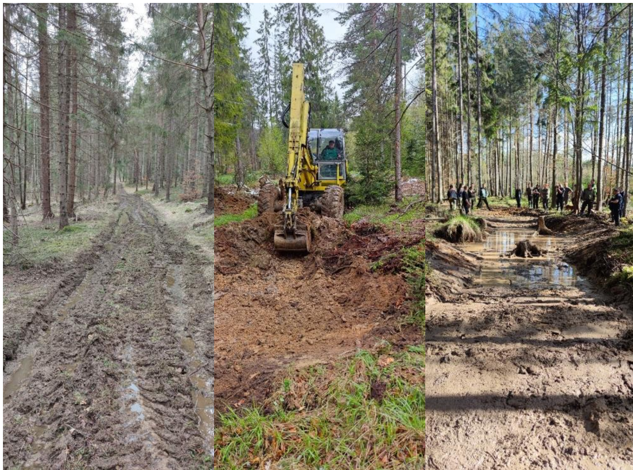
Obrázok 8 Odstránenie nepoužívanej cesty formou prekopenia vrchnej vrstvy a vytvorenia retenčných jazierok s litorálom. So stavom pred, počas prác a po skončení prác – počas školenia o obhospodarovaní mokradových lesov
