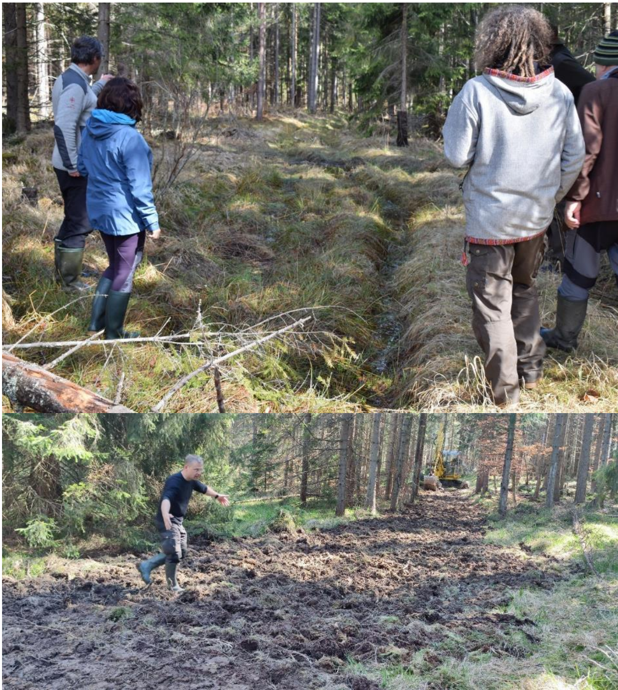
Obrázok 7 Odstránenie cesty formou prekopenia hornej vrstvy a vytvorením vsakovacích a infiltračných prvkov so stavom pred a počas realizácie
