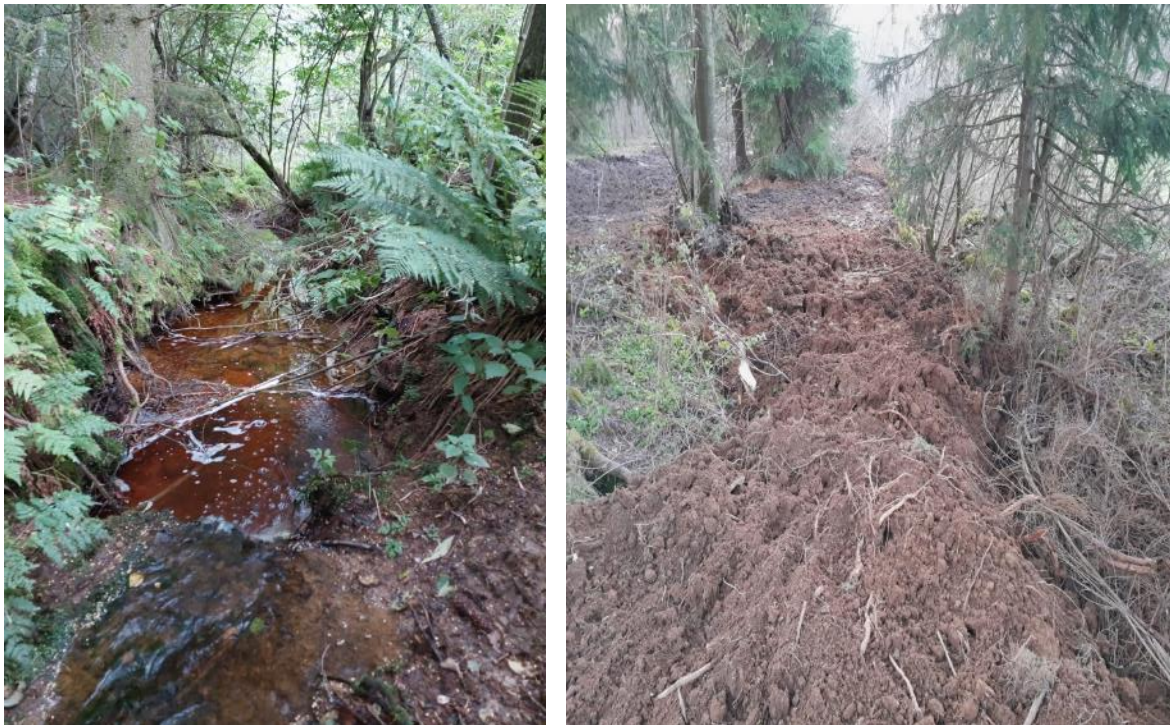
Foto 8 – zasypanie napojenia kanála 2 na kanál 1, záber pred a po vykonaní opatrenia
