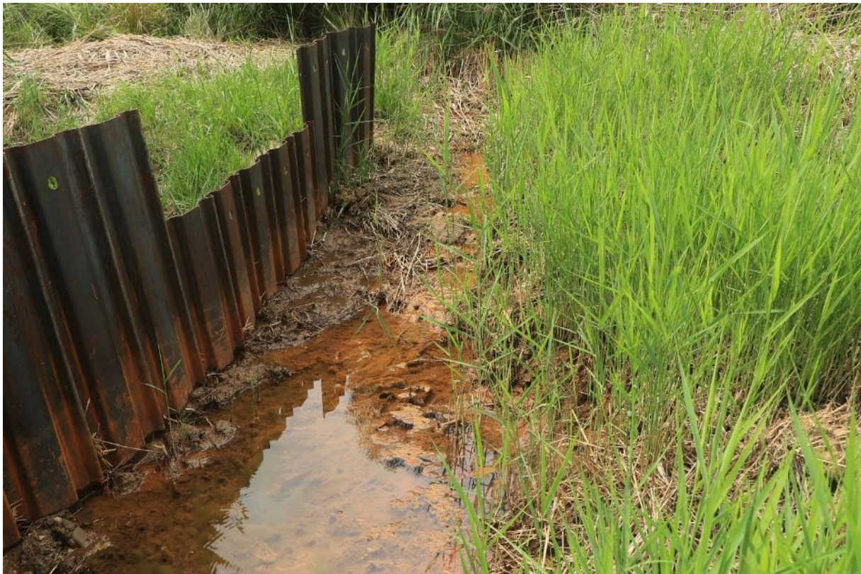
Obr. 2. Dokončená larsenová stena
