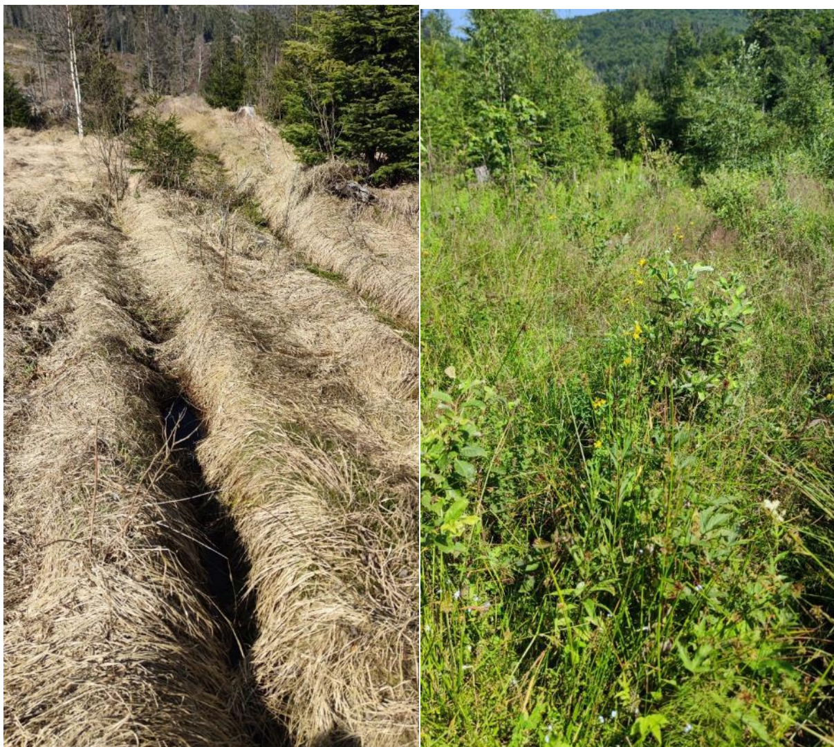
Obrázok č.4 : Revitalizácia lesnej cesty formou prekopenia utlačených vrstiev cesty, s infiltračnými prvkami po okrajoch, stav pred a po realizácii
