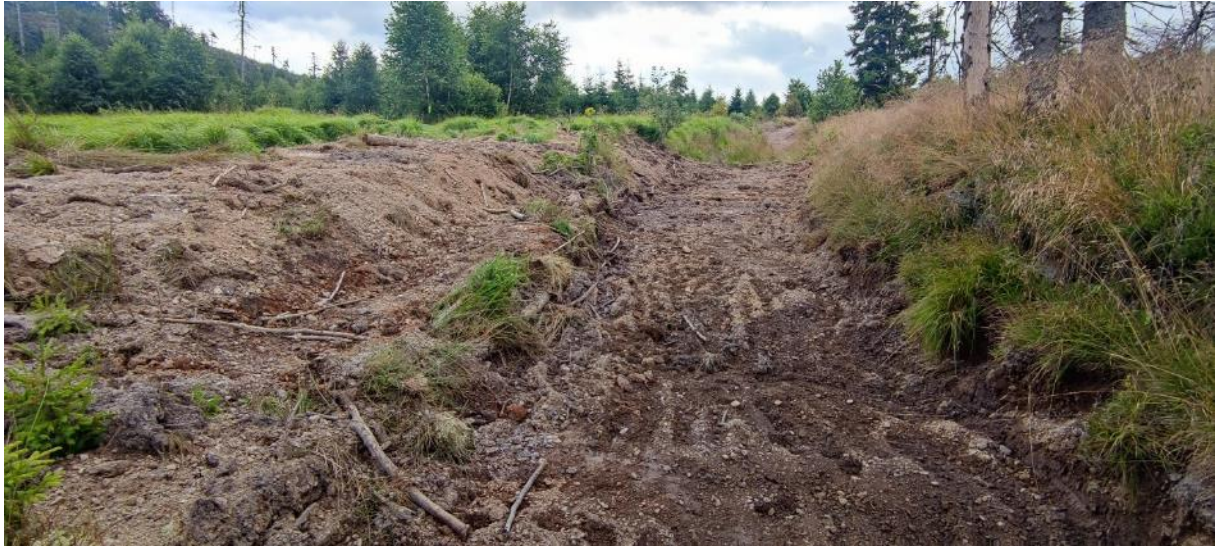
Fotodokumentácia - Obrázok 5: Úprava odvoznjej cesty a zasypanie kanála (približovacej linky) na okraji slatiny, so zamedzením prenikania rýchlotočúcej vody do rašeliniska
