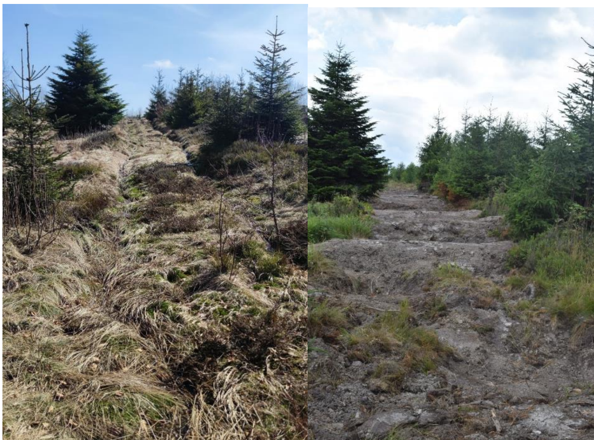
Fotodokumentácia - Obrázok 3: Revitalizácia nepotrebných liniek metódou Jama-Hrádza-Jama, stav pred a po realizácii
