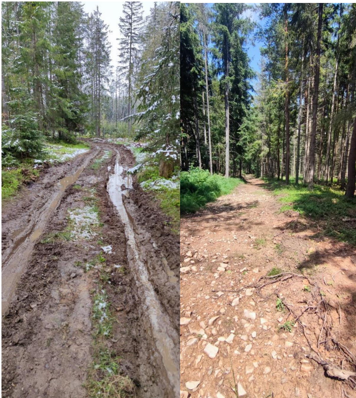
Obrázok 9 Úprava používanej lesnej cesty s rozhrabaním vrchnej vrstvy a doplnením kameňom s infiltračnými prvkami na okraji. Stav pred a po realizácii
