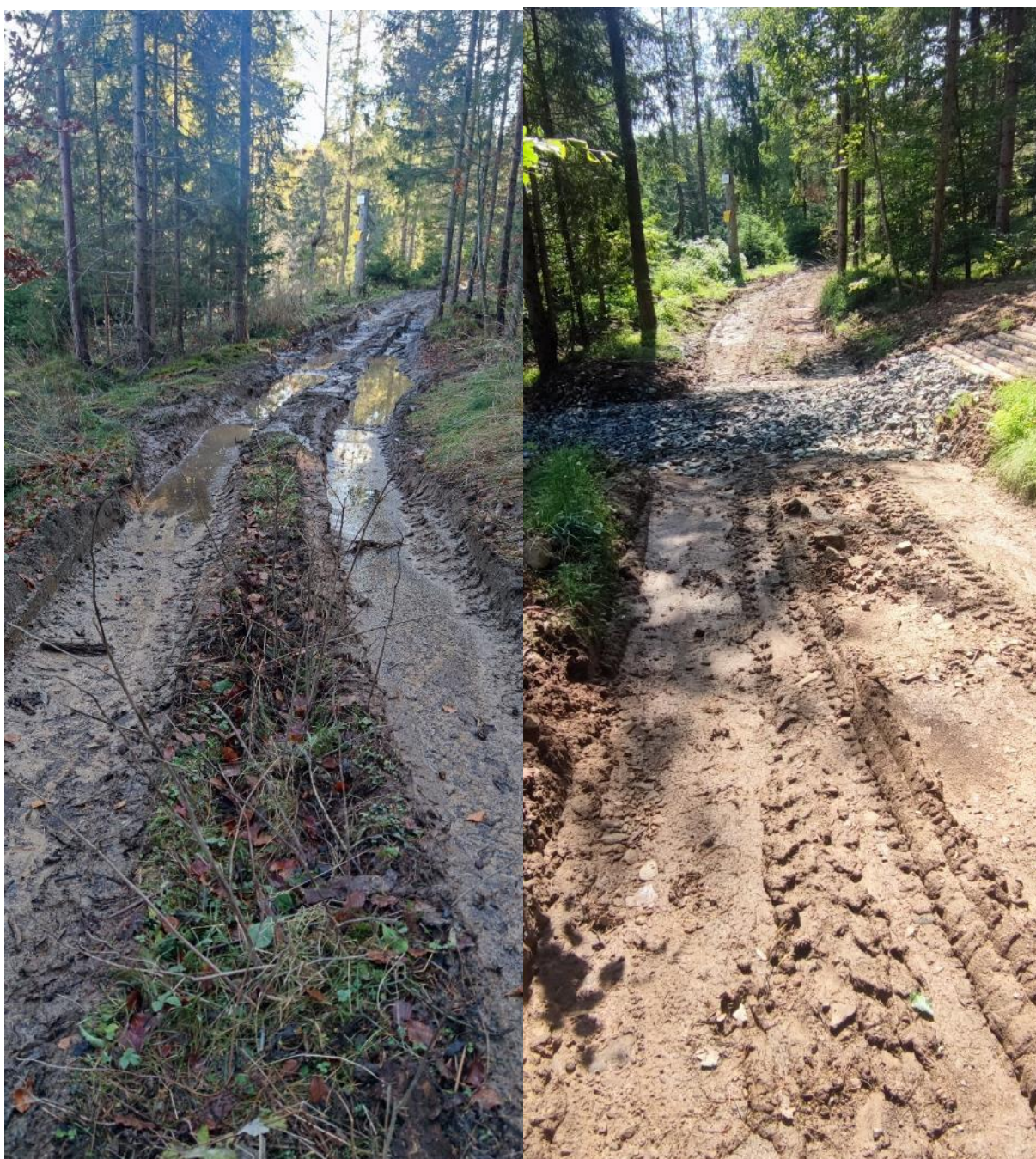
Obrázok č.3 Revitalizácia približovacej cesty na severe lokality pred a po úprave
