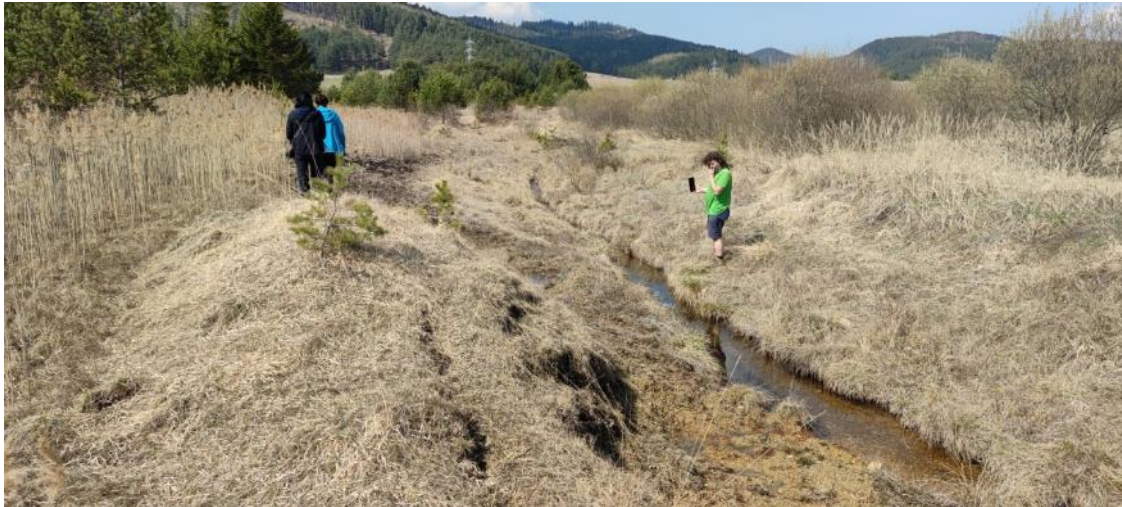
Foto 1 – odstránenie valu 1 a valu 2 a sploštenie brehov hlavného kanála, záber pred, počas a po vykonaní opatrenia
