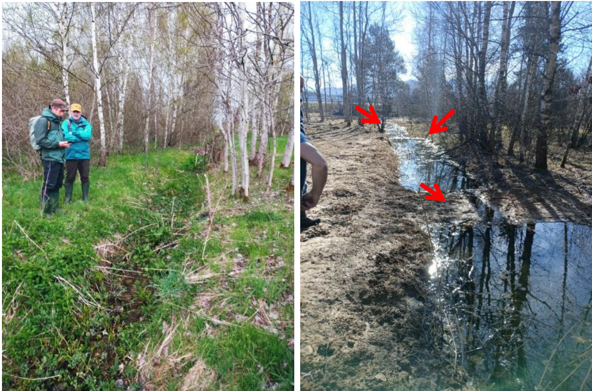
Foto 9 – prehrádzky na kanáli 1, záber pred a po vykonaných opatreniach, šípky ukazujú jednotlivé prehrádzky
