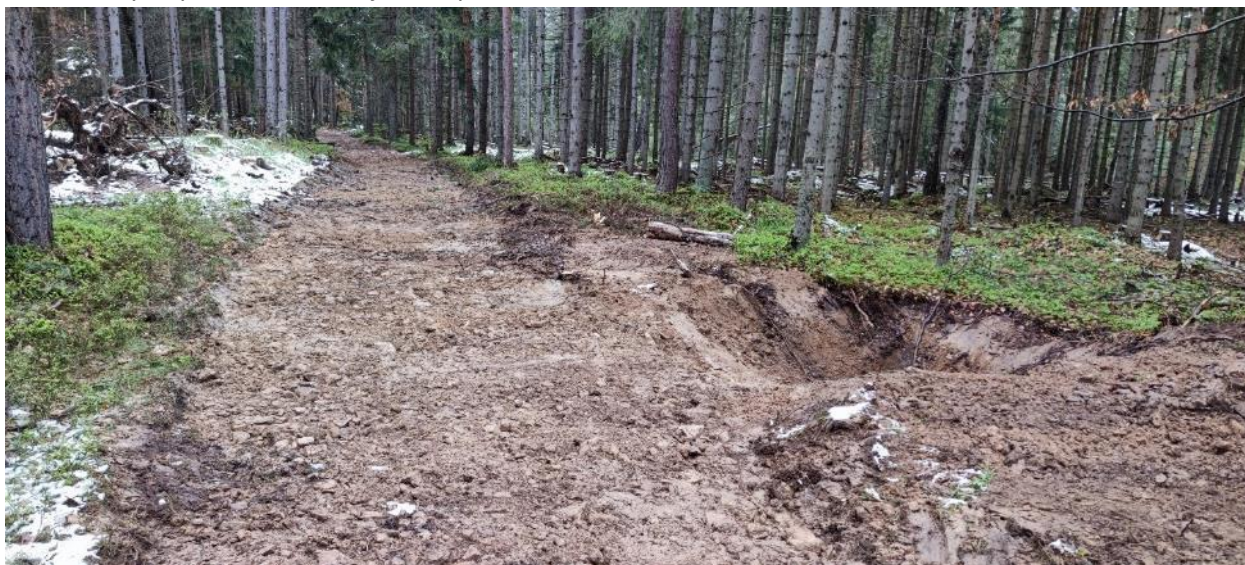
Obrázok 11 Odstránenie nepoužívanej lesnej cesty formou prekopenia vrchnej vrstvy počas prác.
