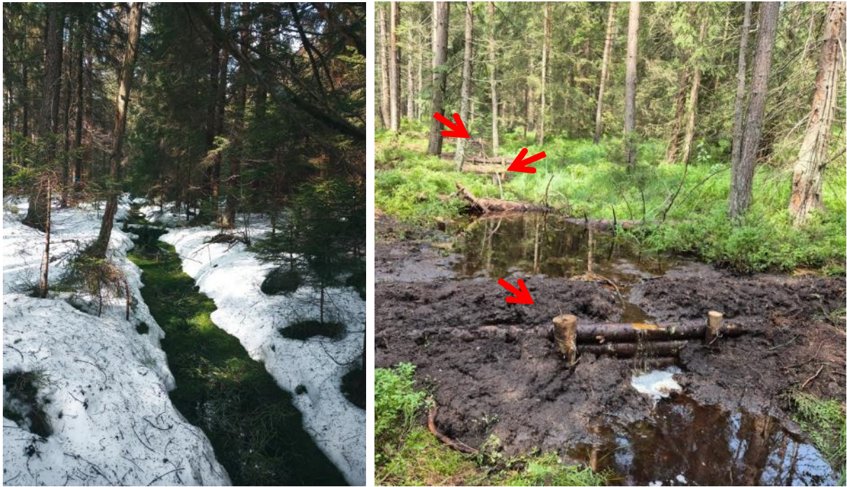
Foto 3 – nové prehrádzky na kanáli 1, záber pred a po vykonaných opatreniach, šípky ukazujú jednotlivé prehrádzky
