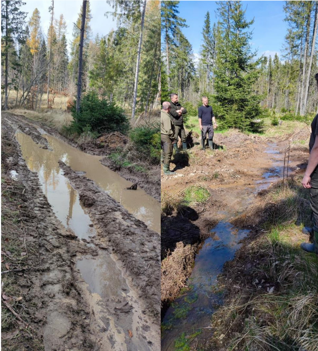
Obrázok č.5 Revitalizácia lesnej cesty formou prekopenia utlačených vrstiev cesty, s infiltračnými a vsakovacími prvkami po okrajoch, stav pred a po realizácii a zároveň ukážka zo školenia lesníkov pri obhospodarovaní mokradových lesov.
