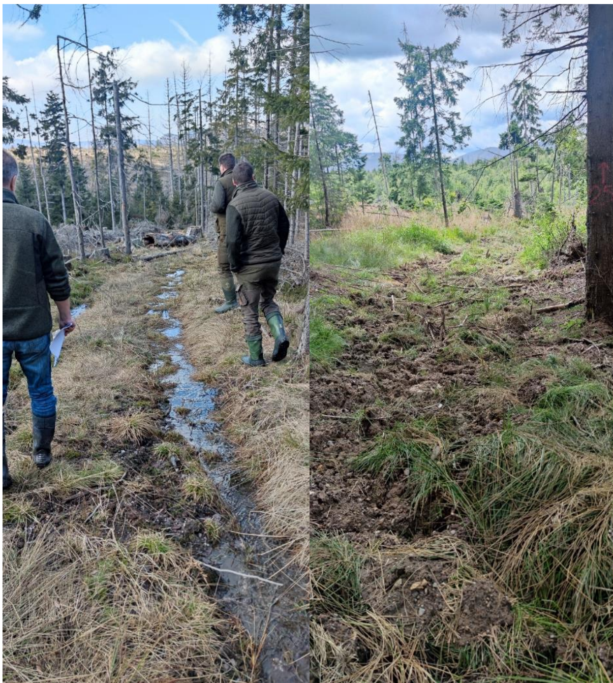
Fotodokumentácia - Obrázok 4: Revitalizácia nepotrebných liniek v miernejších svahoch formou prekopania utlačených vrstiev bývalej cesty, s infiltračnými prvkami po okrajoch, stav pred a po realizácii
